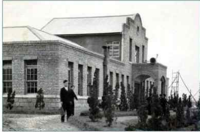
원광대학 1교사 (난방시설, 조적식 입면)
